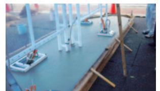
ゲート機器設置用アイランド基礎打ち工事
