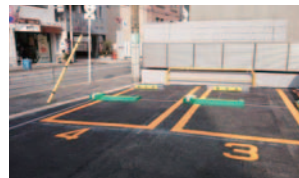
フラップ板設置
