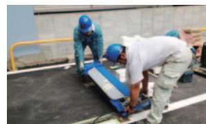
フラップ板設置工事
