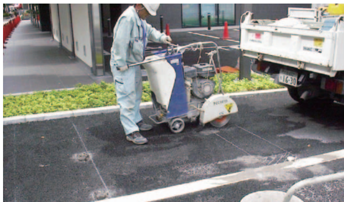
路盤カッター工事
